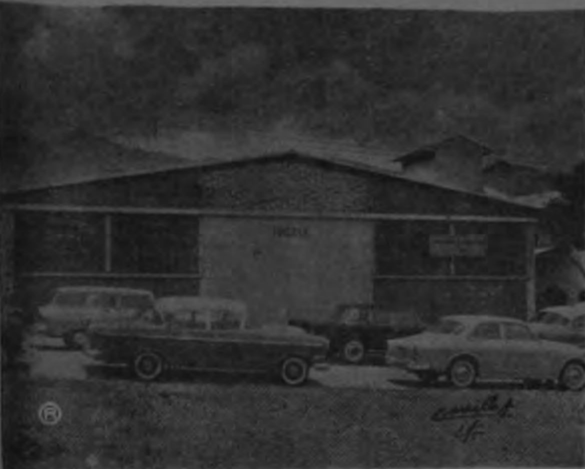
Vista exterior de las modernas instalaciones de PINCASA COSTA RICA LTDA., construidas de acuerdo con la técnica requerida para la elaboración de pinturas, esmaltes y barnices. Se encuentran situadas en Pavas. (Foto Carrillo).
